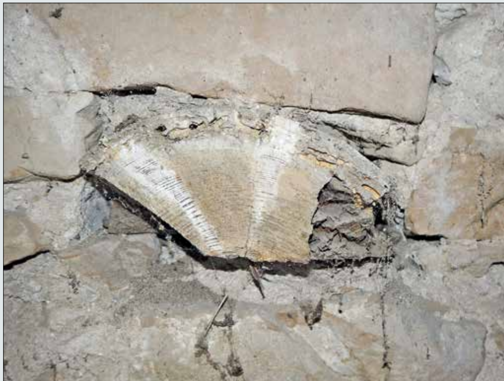
Zhlaví jižněji umístěného trámu ve věži kostela nesoucího původní podlahu příslušného patra
