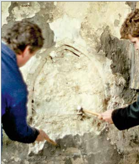
Odstranění zazdívky staršího sanktuáře
