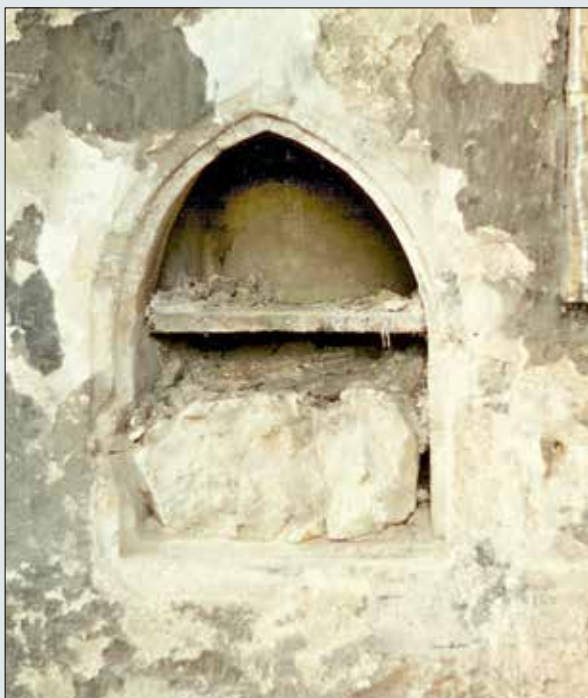
Odstranění zazdívky staršího sanktuáře
