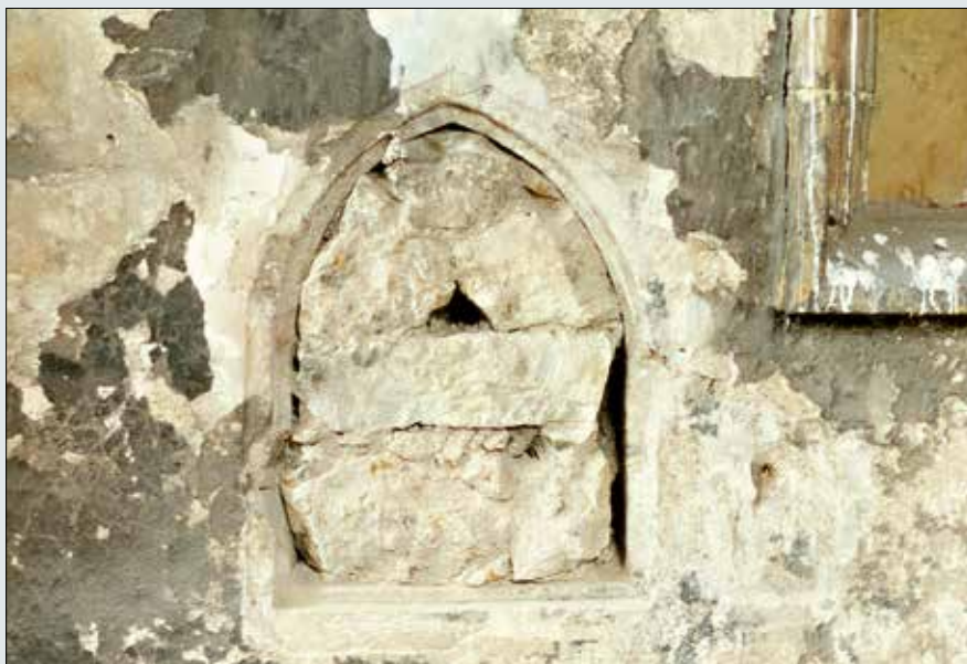
Odstranění zazdívky staršího sanktuáře
