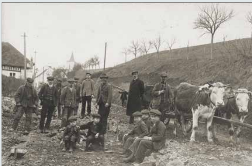
Výstavba silnice z Jílového do Kamenného Přívozu, v pozadí liniová výsadba slivoní, 30. léta 20. století
