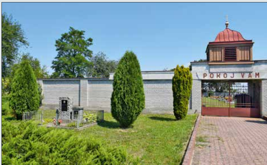
Vstupní prostor hřbitova v Čilci z roku 1938 je typickou ukázkou prvorepublikové architektury Foto Stanislav Svoboda, 2018
