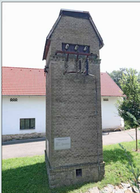
Trafostanice v Nedvězí – jihozápadní stěna nad říčkou Rokytou
