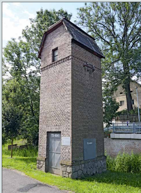
Trafostanice v Nedvězí – severní pohled
