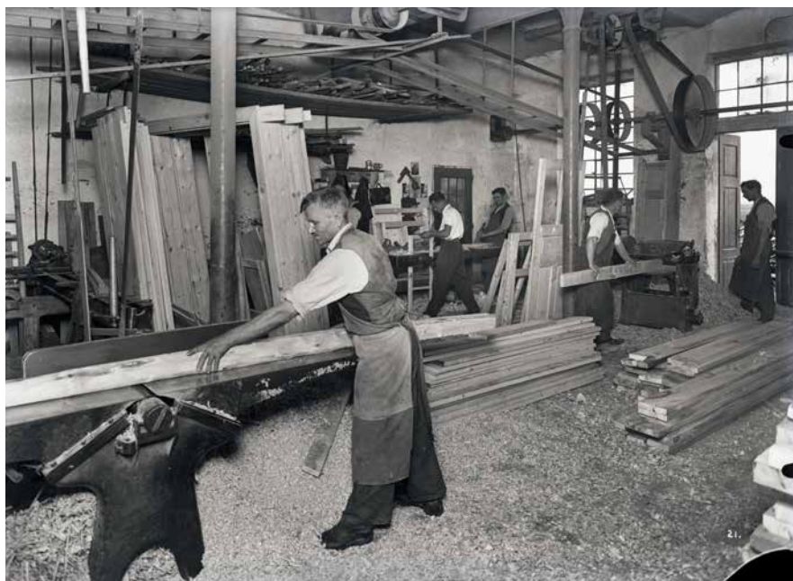
Interiér strojní truhlárny z 1. čtvrtiny 20. století s dobře patrnou výrobou stavebně truhlářských výrobků. Archiv Národního technického muzea, fond č. 800.
